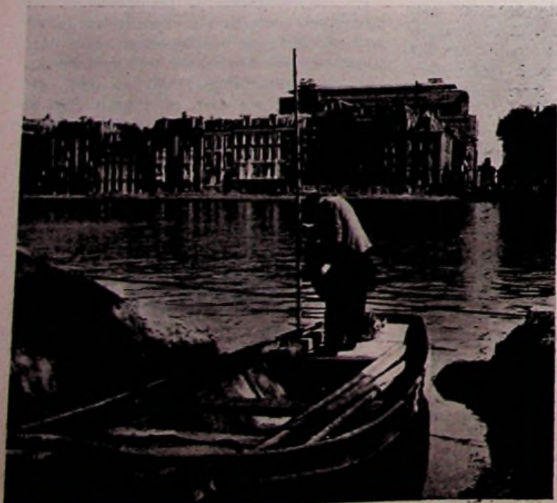
Vanuit de vlet wordt gepeild, of de kabels op de juiste diepte liggen
